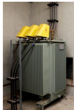
MS/LS-transformator
