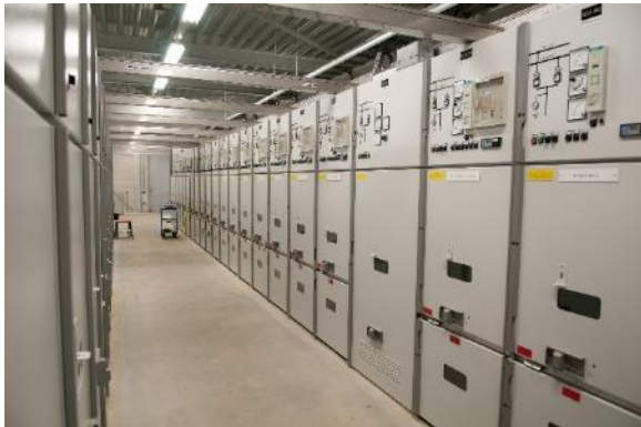
Grote MS-schakelinstallatie
