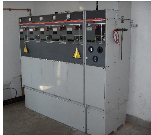
Kleine MS-schakelinstallatie
