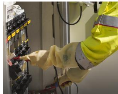
Laagspanningszekeringen vervangen
