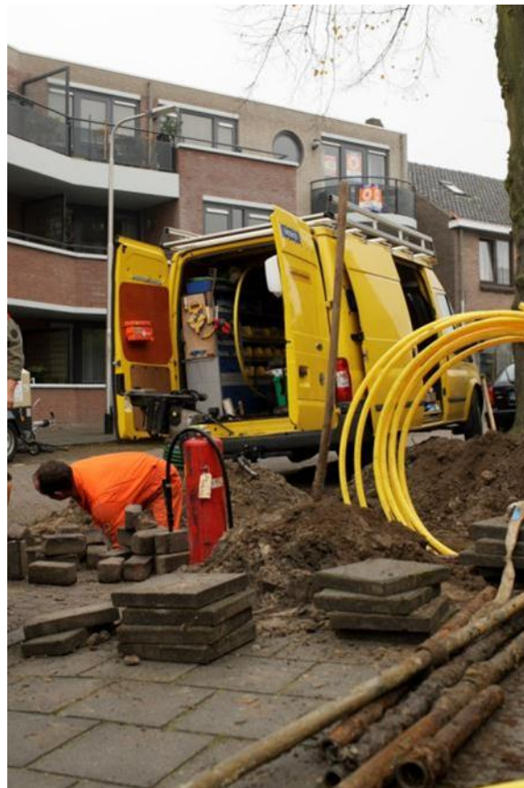
Vervangen aansluitleidingen
